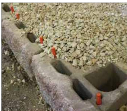
Diagram 6 -- Core Fill
