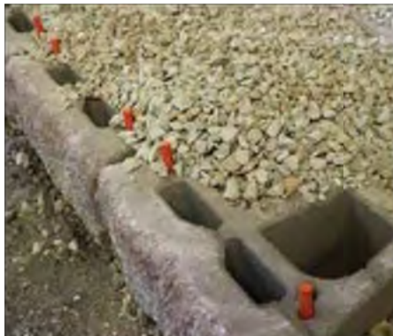
Diagram 6 - Core Fill
